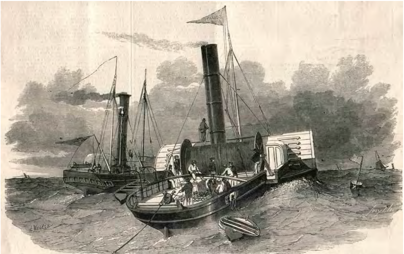
Малюнок 23 – Роботи з прокладення трансатлантичного кабелю
