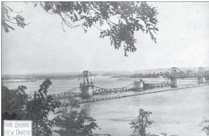
Зруйнований залізничний міст ім. Є. Бош через Дніпро.
